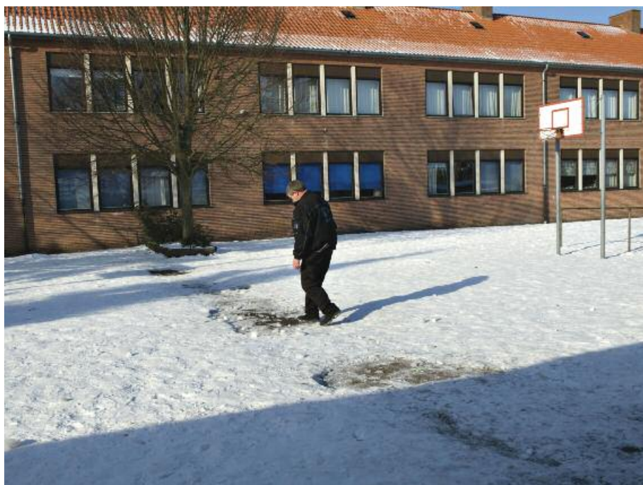
Sneen sladrer. En varmekanal går tværs over gården til gymnastiksalen og skaber en snefri sti.
